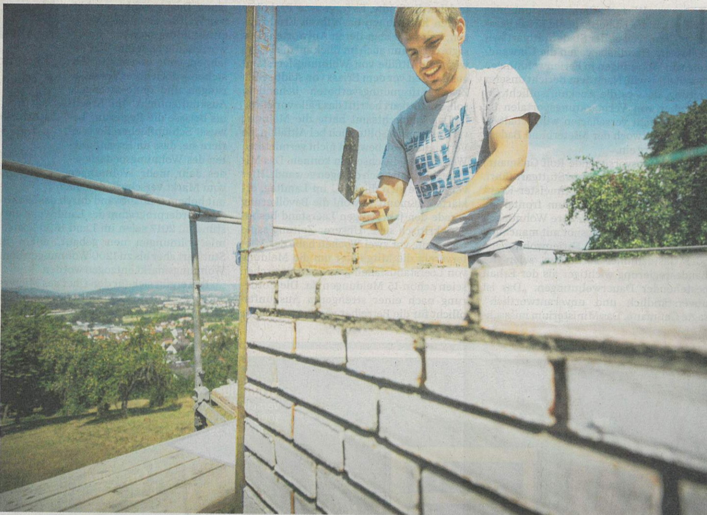
Am Lochtobel bei Plüderhausen wird gerade die erste von insgesamt 16 Stationen gebaut. Das interkommunale Architekturprojekt soll verbindendes Aushängeschild der Remstal-Gartenschau sein.
